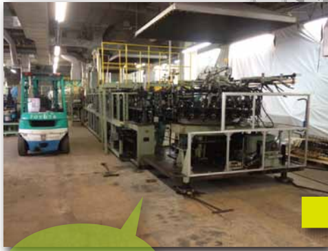
解体搬出準備
